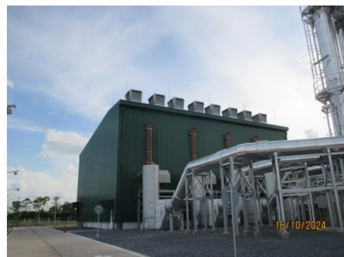
รูปที่ 3-6 อาคารคลุมเครื่องจักรที่บริเวณห้องเผาไหม้ของเครื่องยนต์ผลิตไฟฟ้าจากก๊าซธรรมชาติ (Gas Engine)
