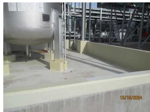
รูปที่ 3-46 คันกั้น (Dike) บริเวณจัดเก็บสารเคมี
