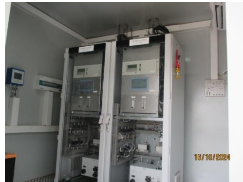
รูปที่ 3-2 ระบบตรวจวัดการระบายมลสารทางอากาศแบบต่อเนื่อง (CEMS)
