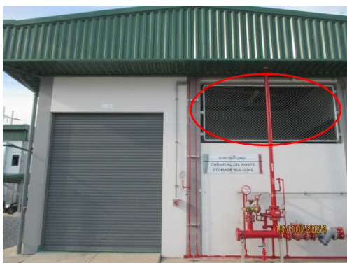
รูปที่ 3-45 ระบบระบายอากาศบริเวณ จัดเก็บสารเคมี
