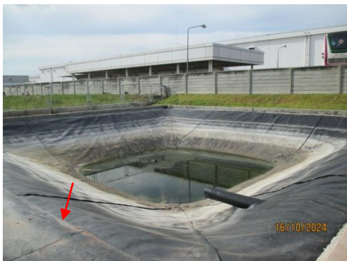
รูปที่ 3-11 การปูพื้นบ่อบำบัดน้ำทิ้งด้วย HDPE
