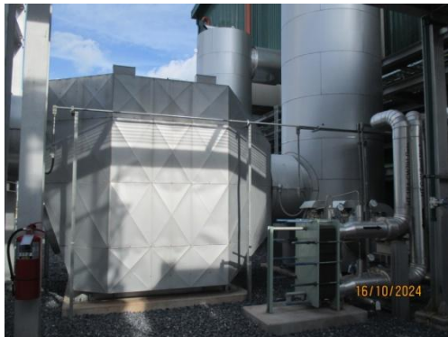
รูปที่ 3-1 ระบบ Selective Catalytic Reduction (SCR)
