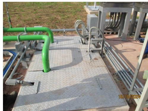
รูปที่ 3-12 บ่อบำบัดน้ำทิ้งที่ตรวจสอบคุณภาพน้ำ (Inspection Pit)
