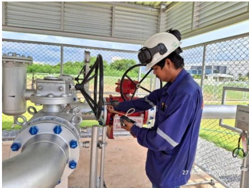
รูปที่ 3-53 การใช้ Portable Gas Detector ตรวจจับการรั่วไหลของก๊าซธรรมชาติ บริเวณสถานี MRS
